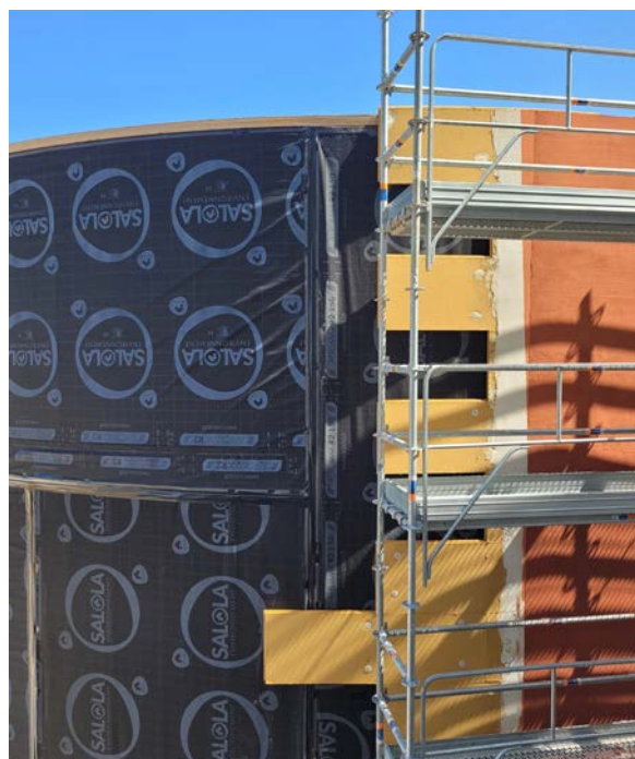
L'ITE a été réalisée en fibre de bois sous enduit
