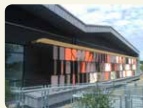
Maître d'ouvrage : FFB Compiègne
