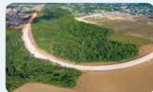
Déviations d'Etampes 2 km entre Etampes et Brières-les-Scellés
