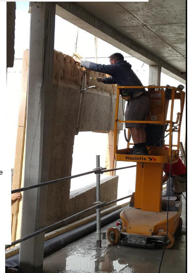
Pose des panneaux en chantier
